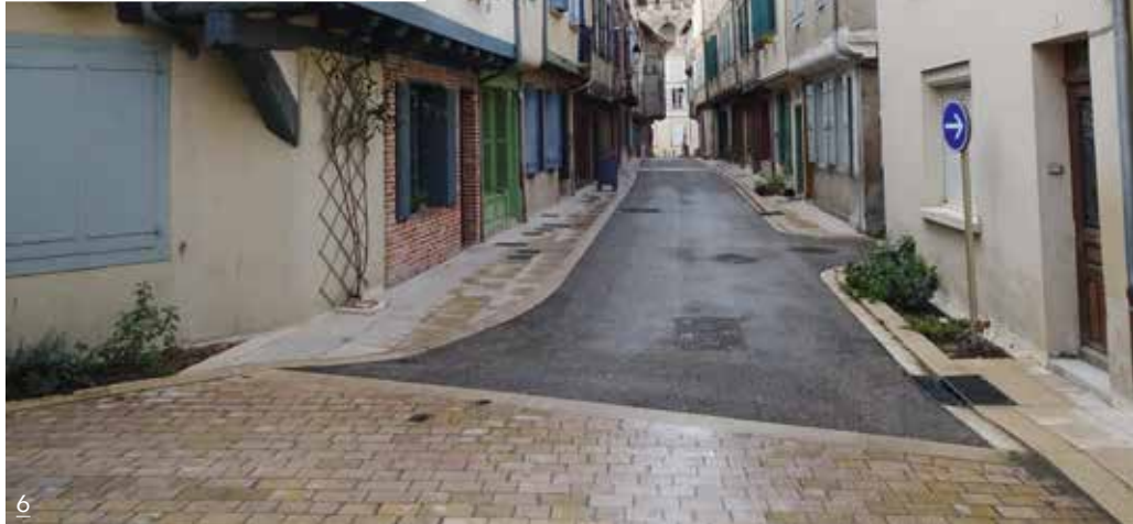
5-6/ La rue du Maquis se compose d'une bande circulée en enrobé grenailé et d'emprises piétonnes en dalles calcaires pour une composition sobre et sans raccords altimétriques.
