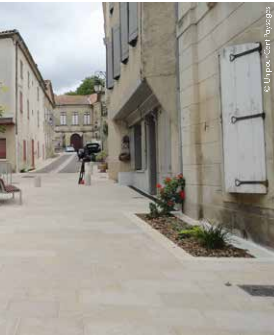
5-6/ La rue du Maquis se compose d'une bande circulée en enrobé grenailé et d'emprises piétonnes en dalles calcaires pour une composition sobre et sans raccords altimétriques.
